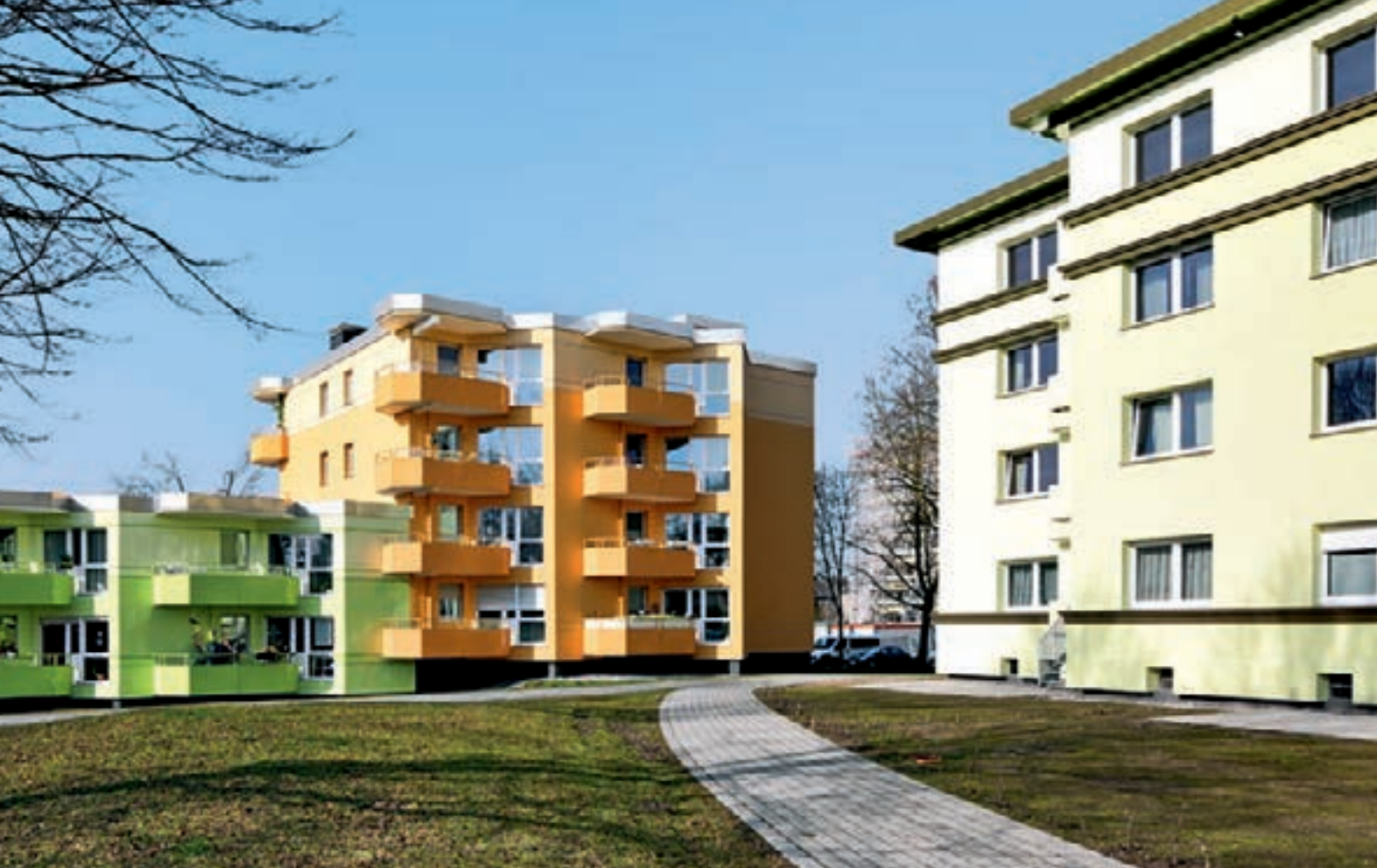
Revitalisierung einer Großwohnsiedlung: Neue Stadtgärten in Recklinghausen
