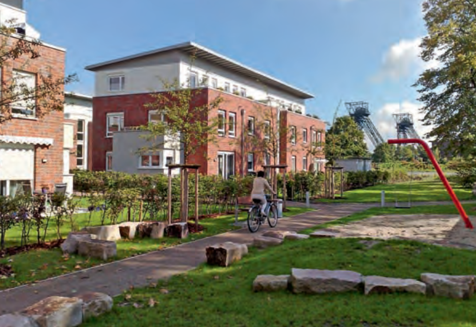
Häuser in Marl nutzen Tiefenerdwärme, die aus einem stillgelegten Schacht des Bergwerks Auguste Victoria kommt
