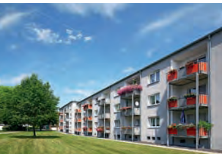
Planetensiedlung in Duisburg nach der Modernisierung 2013
