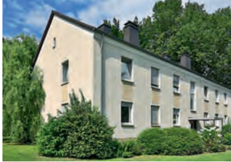
Die Häuser am Morgengraben sind Teil eines größeren Quartiers im Kölner Stadtteil Stammheim, das umfassend saniert wird
