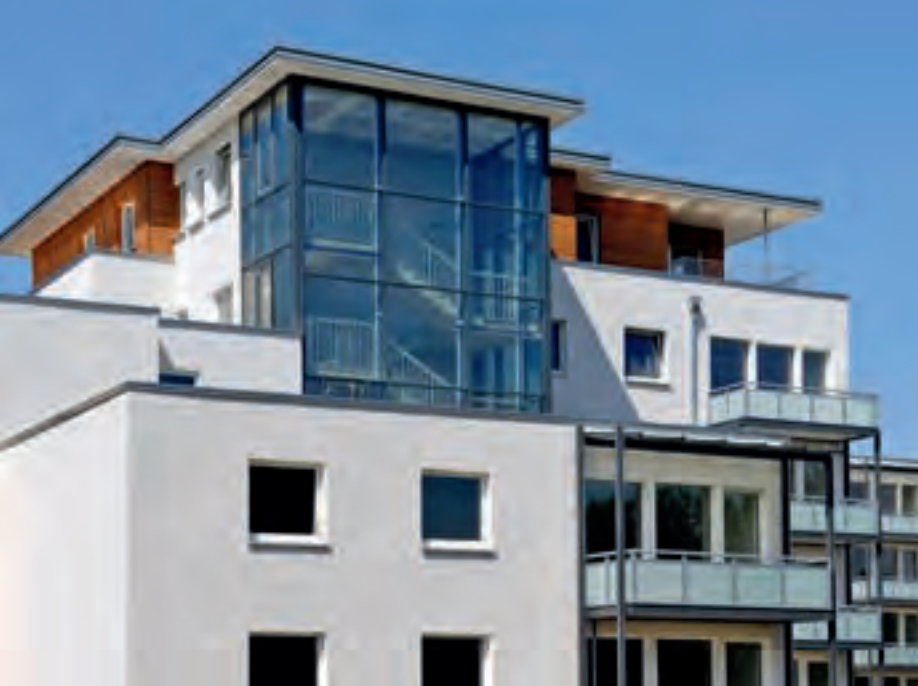
Erfolgsprojekt im Stadtumbau West: Im Schillerpark in Oer-Erkenschwick wurden Teilrückbau und Neubau miteinander kombiniert
