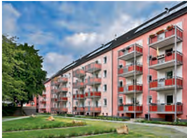
Stahlbalkonanlagen und eine neue Fassadengestaltung zeichnen Häuser in der Lünener Straße in Dortmund nach dem Umbau aus
