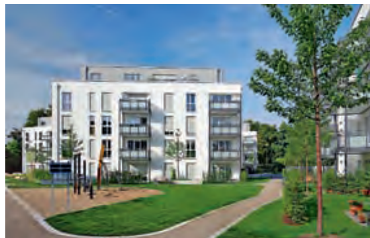
Größte deutsche Eisspeichersiedlung im Kölner Stadtteil Porz
