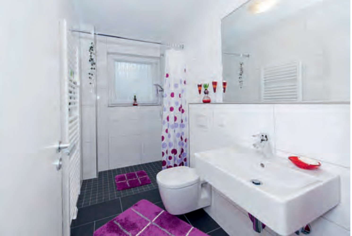
Badezimmer nach dem Umbau und dem Tausch der Wanne gegen eine Dusche ohne Duschtasse
